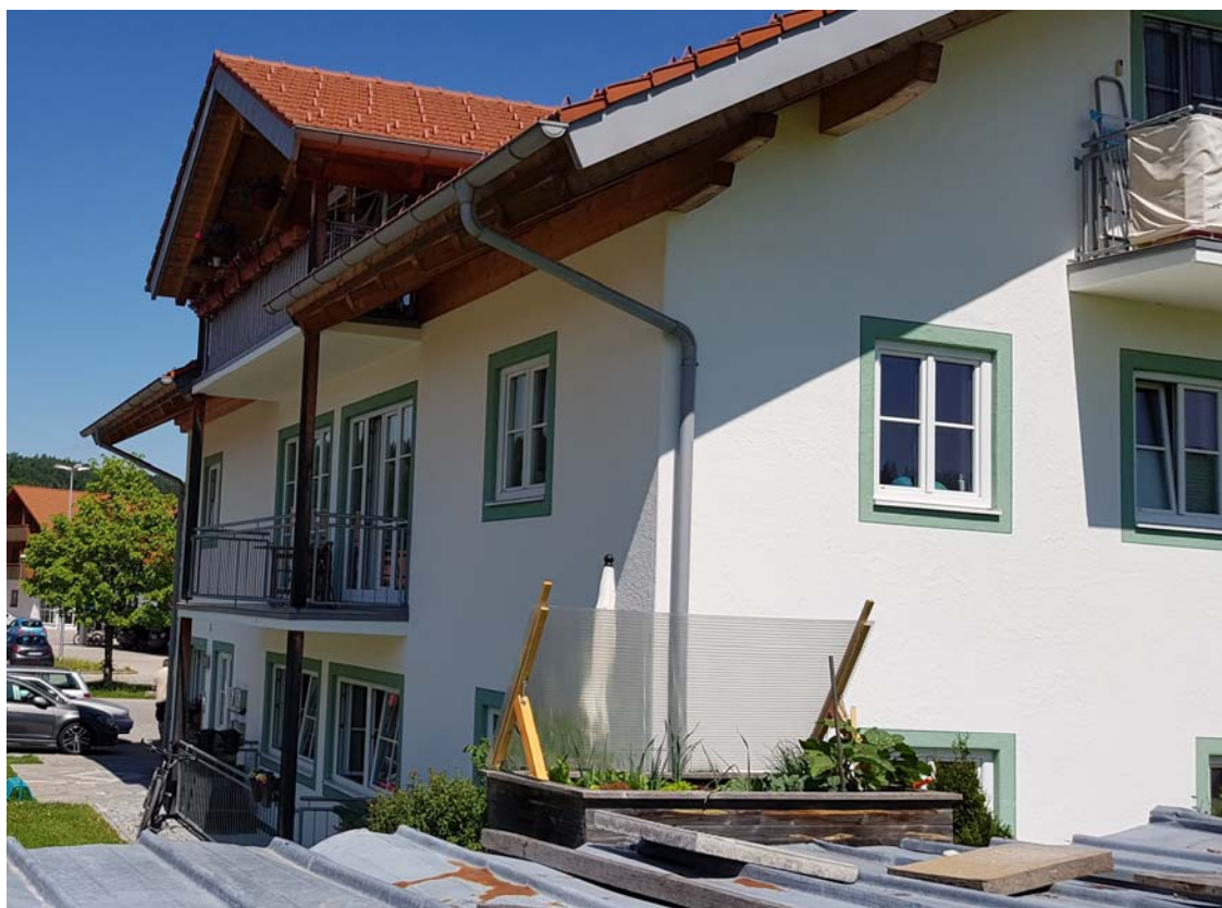
Bild A2: GGH, Südost-Ansicht
