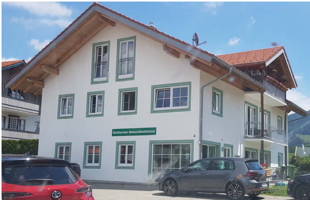
Bild A1: GGH (Gaißacher Gesundheitshaus), Südwest-Ansicht
