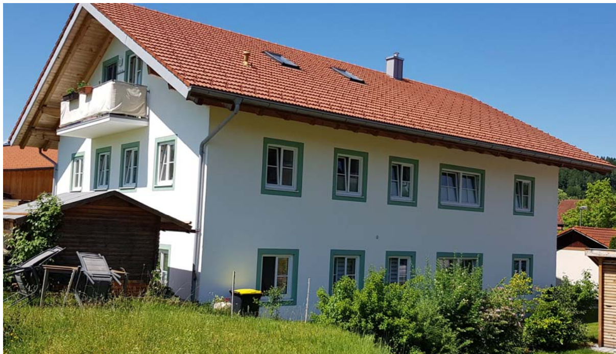
Bild A3: GGH, Nordost-Ansicht
